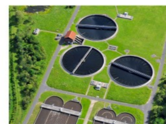
现代化自来水厂新建或膜法深度处理EPC、PPP项目
